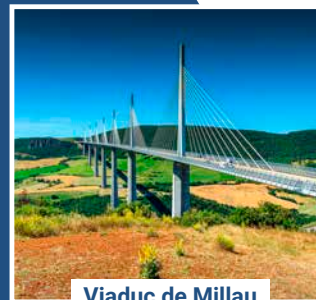
Viaduc de Millau
